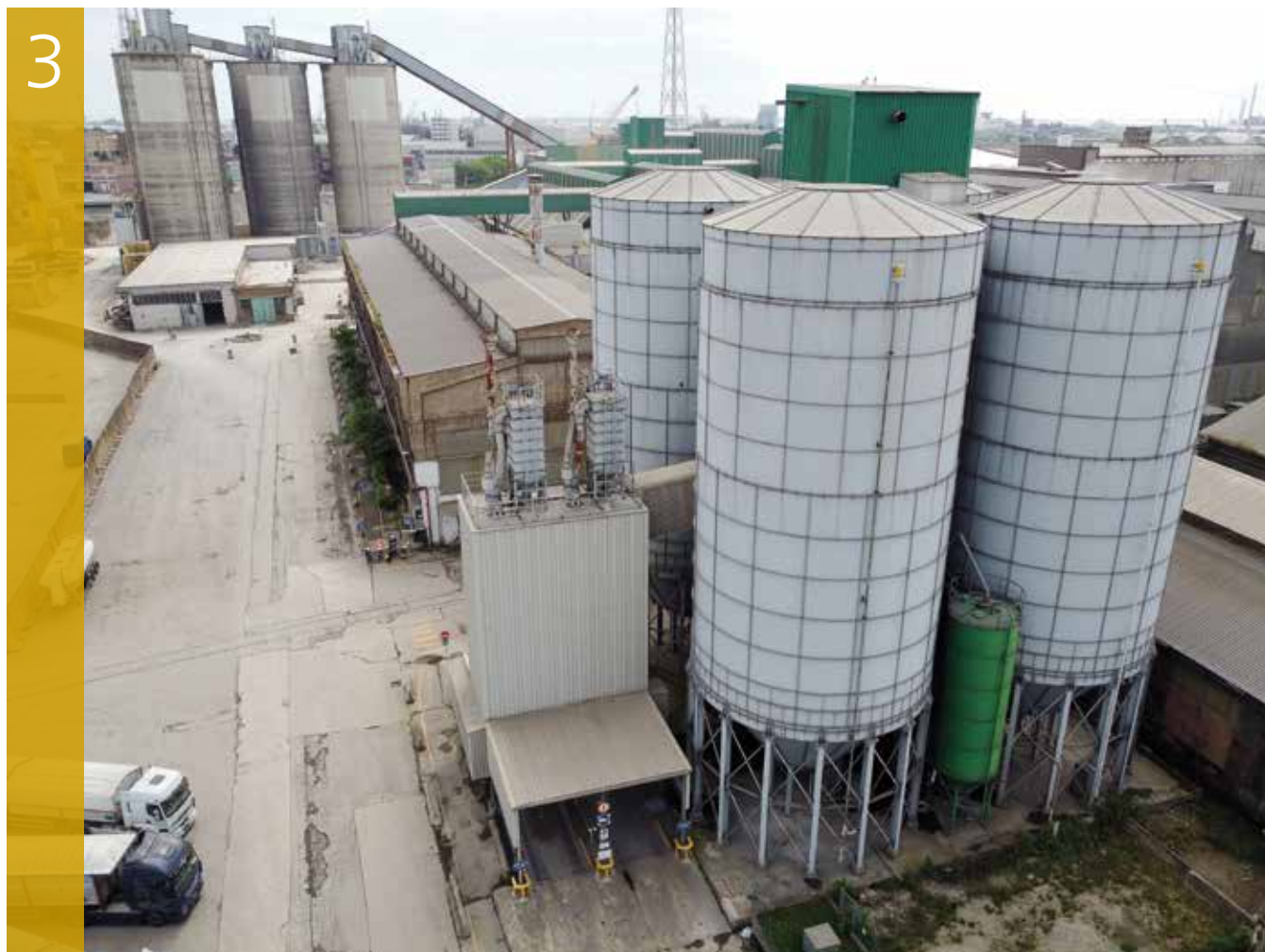
3. IL TERMINAL DI MARGHERA THE MARGHERA TERMINAL
